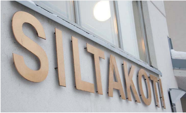
5mm messinki-irtokirjaimet piilotappikiinnityksellä. Siltaapuisto, Heinola.
