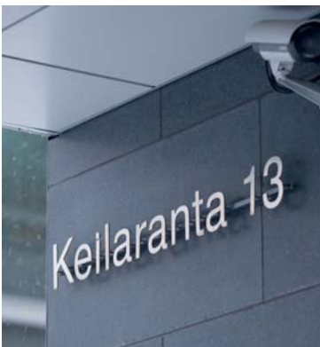
Rst-irtokirjaimet kiskoon kiinnitettynä. Keilaranta 13, Helsinki.
