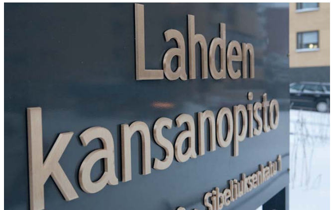
Messinki-irtokirjaimet tummalla pohjalla, piilotappikiinnitys, Lahden kansanopisto.
