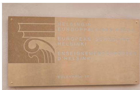
Kaiverrus- ja hiekkapuhallustekniikalla toteutettu messinkikilpi, Helsinki.
