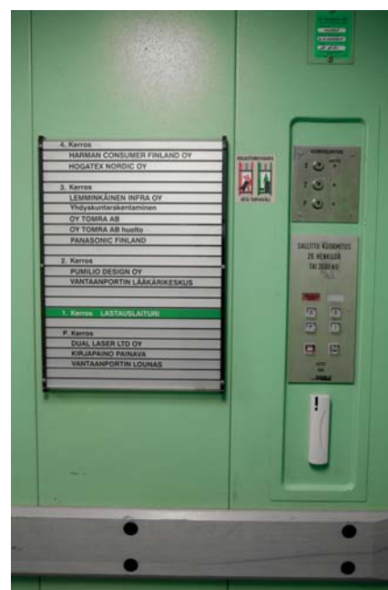
Hissitaulu 20 mm slatz-paneilla, tarratekstein. Panelit suojattu 6 mm kirkkaalla akryylillevyllä.
